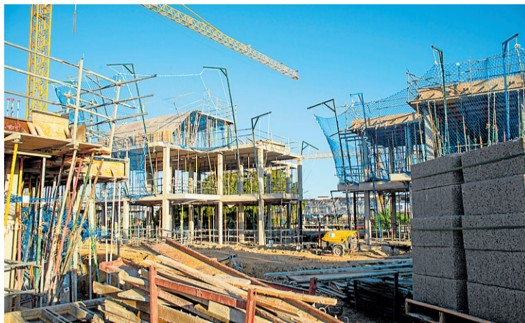
Bau von Wohnungen in Boadilla del Monte (Madrid). ANTONIO LÓPEZ DÍAZ
